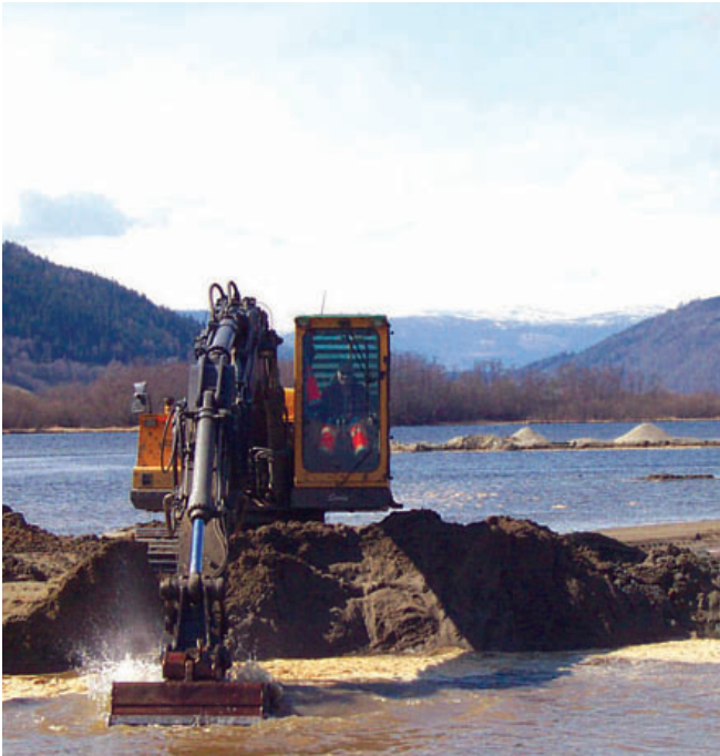
Stabilisering av elveleier og andre inngrep fører til markert endring i leveområder og plante- og dyresamfunn. Fra Gudbrandsdalslågen, Ringebru kommune. Foto: Børre Dervo, Norsk institutt for naturforskning
